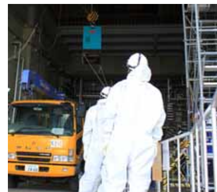
模擬電動機の搬出（4号機タービン建屋）
