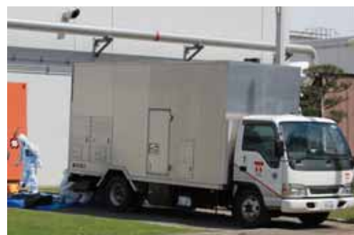
原子炉建屋への電源車の配備（1号機）
