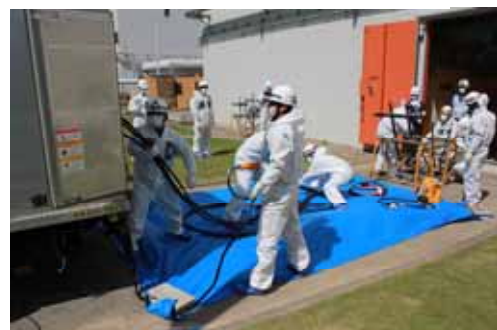
電源ケーブルの接続（1号機）
