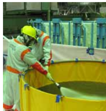
原子炉建屋内仮設プールへの送水状況（4号機）
