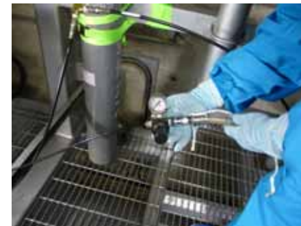
弁駆動用の予備窒素ボンベ設置状況（3号機）
