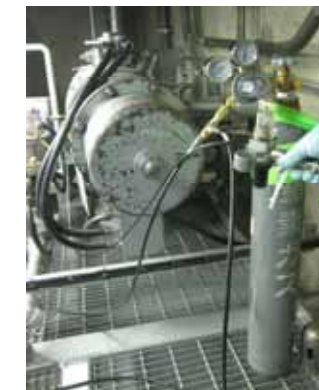
弁駆動用の予備窒素ボンベ設置状況（3号機）
