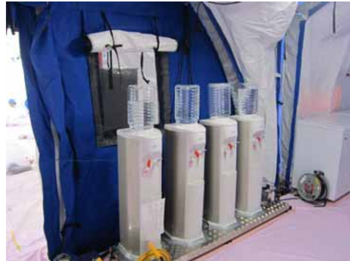
撮影日 : 平成23年5月15日 11時頃 場所 : 休憩所内飲料水設備
