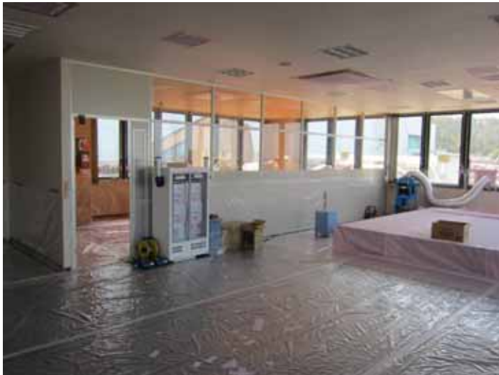
撮影日 : 平成23年5月19日 14時頃 場所 : 休憩所内部
