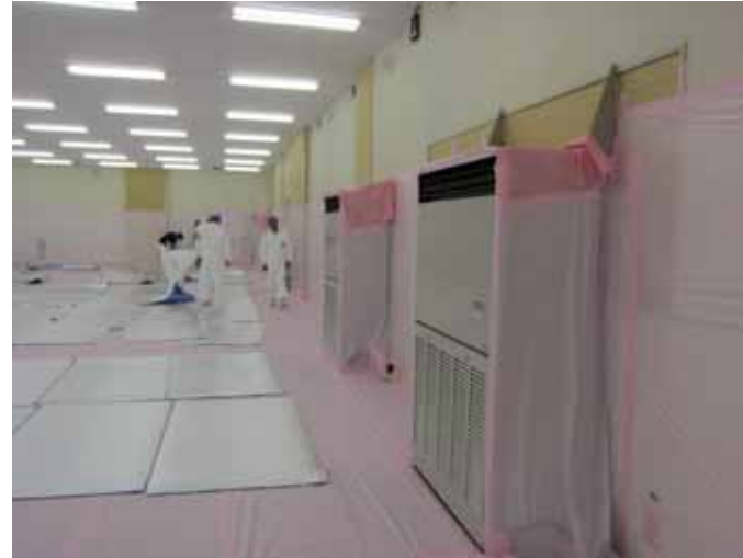
撮影日 : 平成23年6月9日 15時頃 場所 : 休憩所室内部
