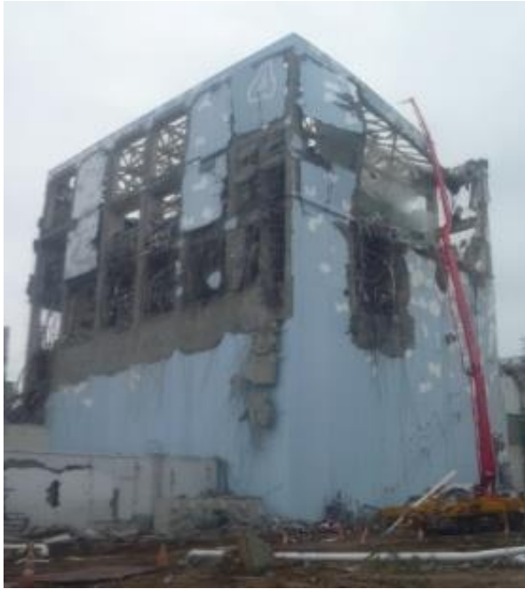
水素爆発後の4号機原子炉建屋
