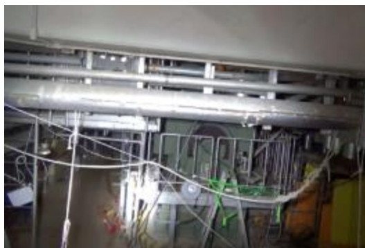
① 3階機器ハッチ北側
