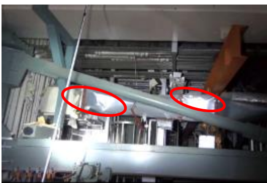
③ 2階機器ハッチ北側
