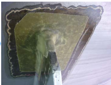
補修材で補修(塗装前)
